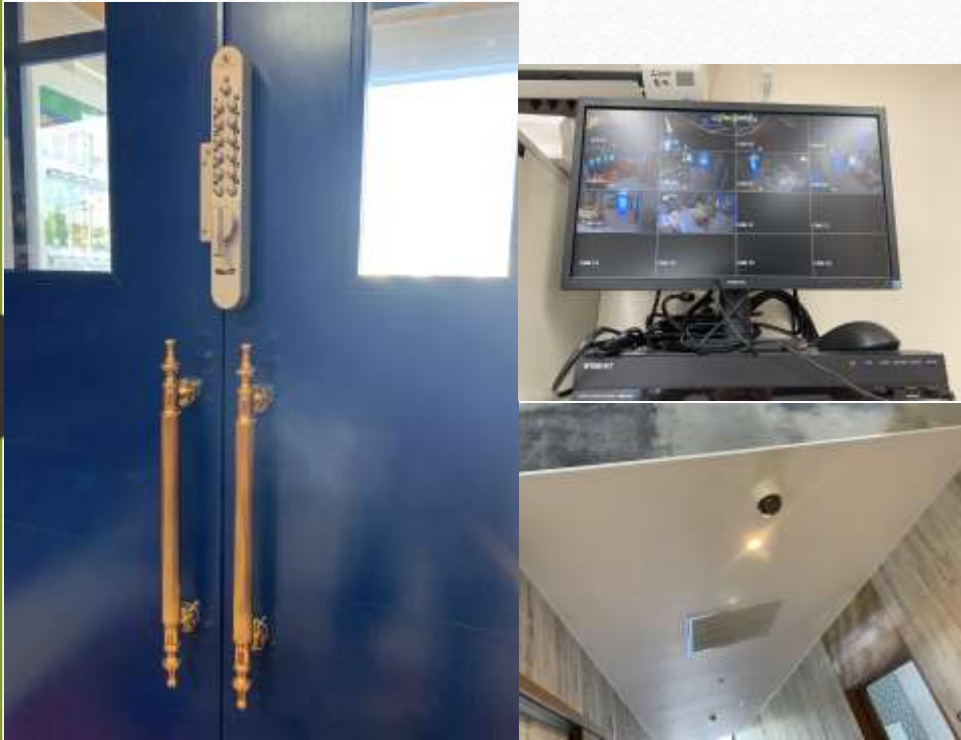
玄関・フロアに設置
